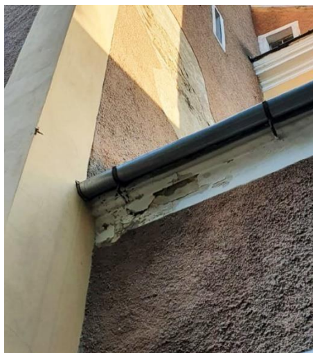
Fot. 44. Ubytki wynikające z zalewania elewacji wodą opadową.
