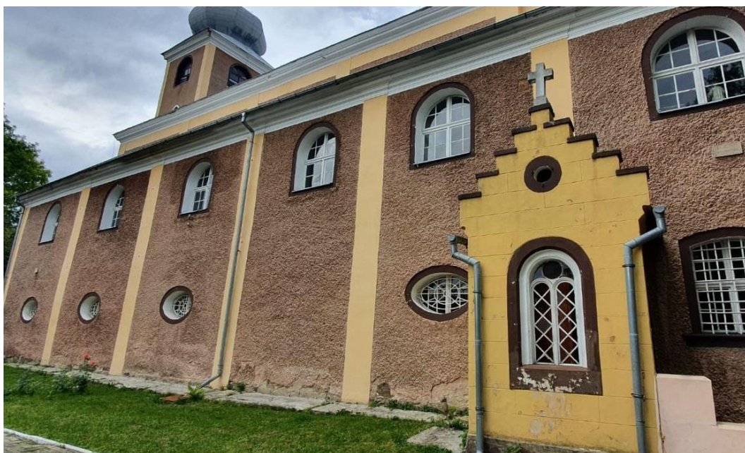
Fot. 50. Przemalowana na ugrowo kruchta z wtórnie brązowym obramieniem. Dobór kolorów na elewacji zaburza jej estetyczny odbiór.
