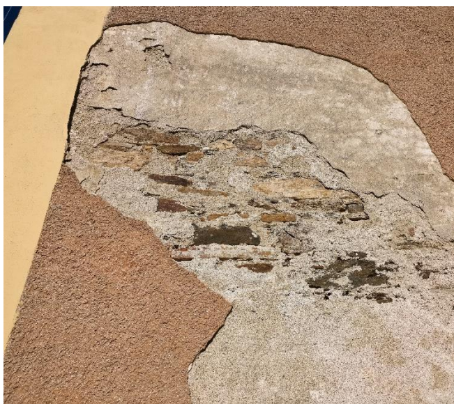
Fot. 26. Elewacja wieży, widoczny rozległy ubytek. Mur wykonany z kamienia. Na nim zachowane resztki wcześniejszej zaprawy z pozostałościami białej pobiałki oraz ugrowej warstwy malarskiej. Jest to warstwa widoczna na fotografii archiwalnej nr z lat 50-tych (fot. 5 i 6).
