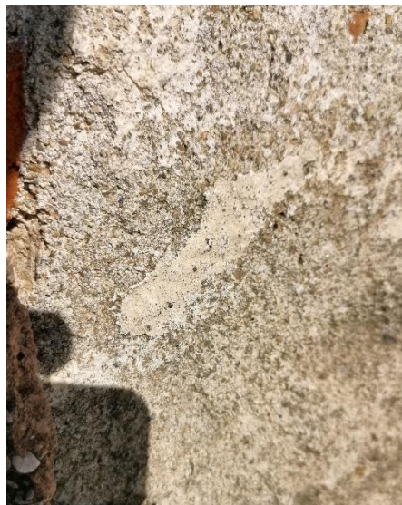
Fot. 28. Pozostałości pobiałej na warstwie nr 4 (zaprawa wapienno-piaskowa, gruboziarnista).
