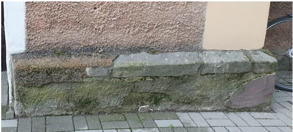
Fot. 47. W miejscach silnie zawilgoconych widać również obecność korozji biologicznej.
