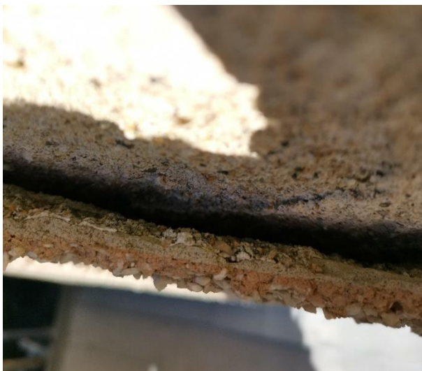
Fot. 42. Ponad 1 cm odspojenia zewnętrznych warstw elewacji od muru. Konieczna szybka interwencja.
