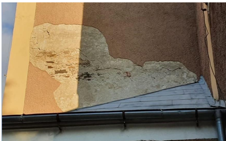
Fot. 41. Rozległy ubytek zapraw na elewacji wieży. Widoczne rozwarstwienia poszczególnych faz chronologicznych i szerokie odspojenia.
