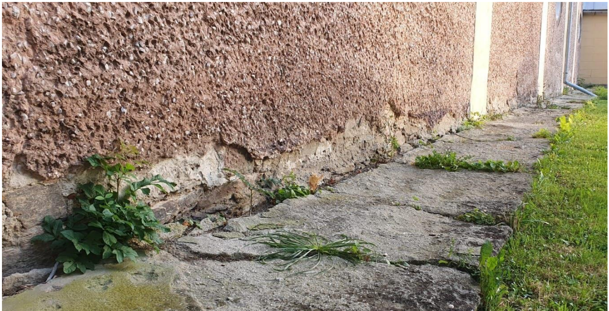
Fot. 46. Opaska betonowa wokół budynku. Widoczne odspojenia tynku w obrębie przyziemia. Dodatkowe zniszczenia spowodowane obecnością roślin i ich systemów korzeniowych.
