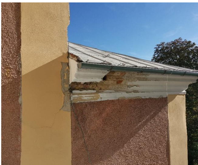
Fot. 43. Uszkodzenie gzymsu, prawdopodobnie spowodowane lokalnym zalewaniem wody z dachu i rynny przy silniejszych opadach.
