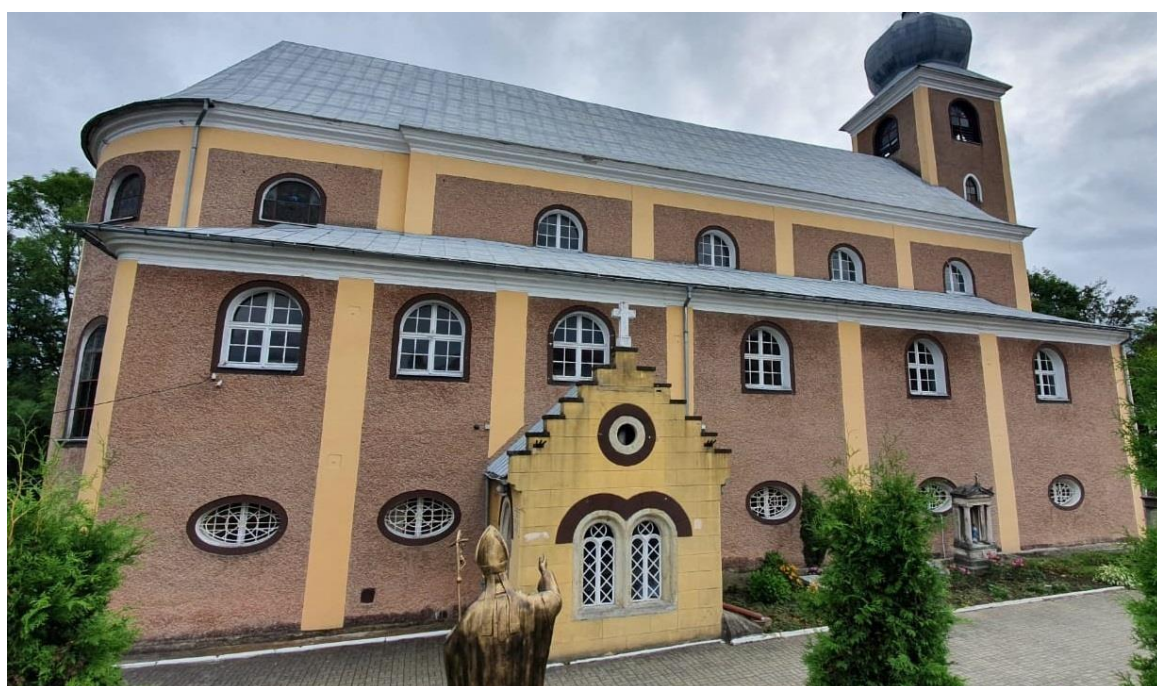
Fot. 51. Nieestetyczny wygląd elewacji oprócz źle dobranych kolorów potęgują widoczne na nich zabrudzenia powierzchniowe i zacieki, np. na kruchcie.
