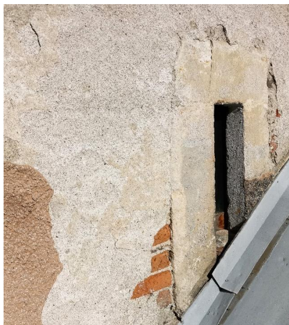
Fot. 30. Obramienie wąskiego okienka wykonano z piaskowca. Na nim widoczne resztki białej pobiałą oraz ugrowej warstwy malarskiej.
