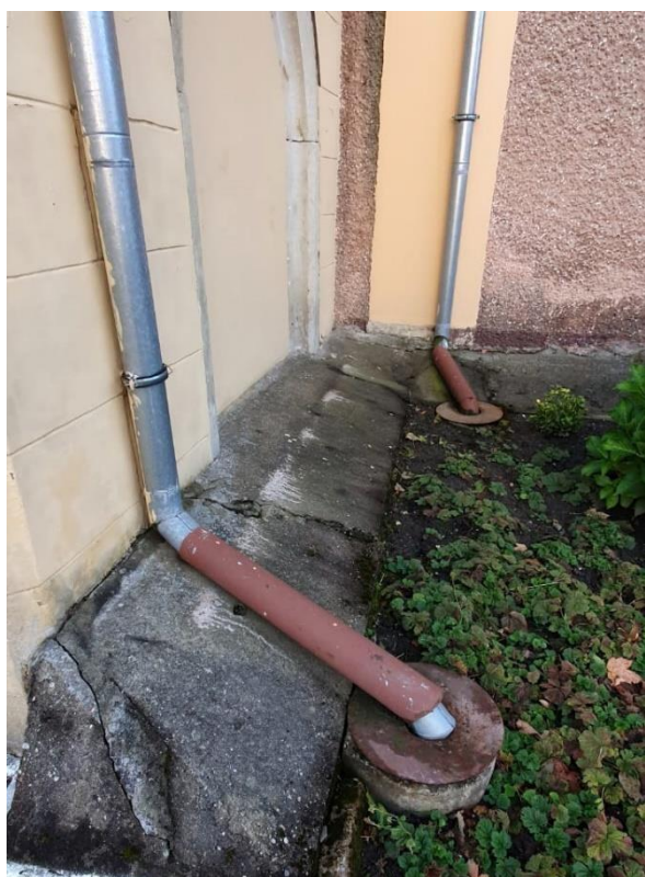
Fot. 45. Odwodnienie z systemem studzienek. Gruba opaska betonowa wokół budynku.
