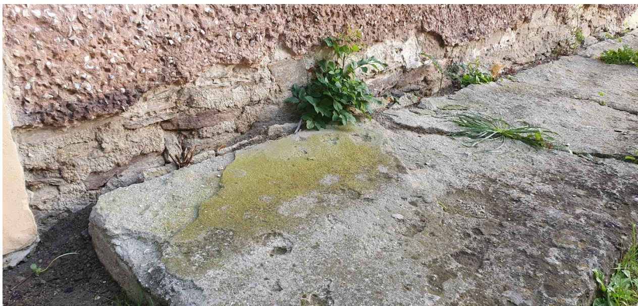
Przyziemie elewacji południowo wschodniej z istniejącą opaską betonową.
