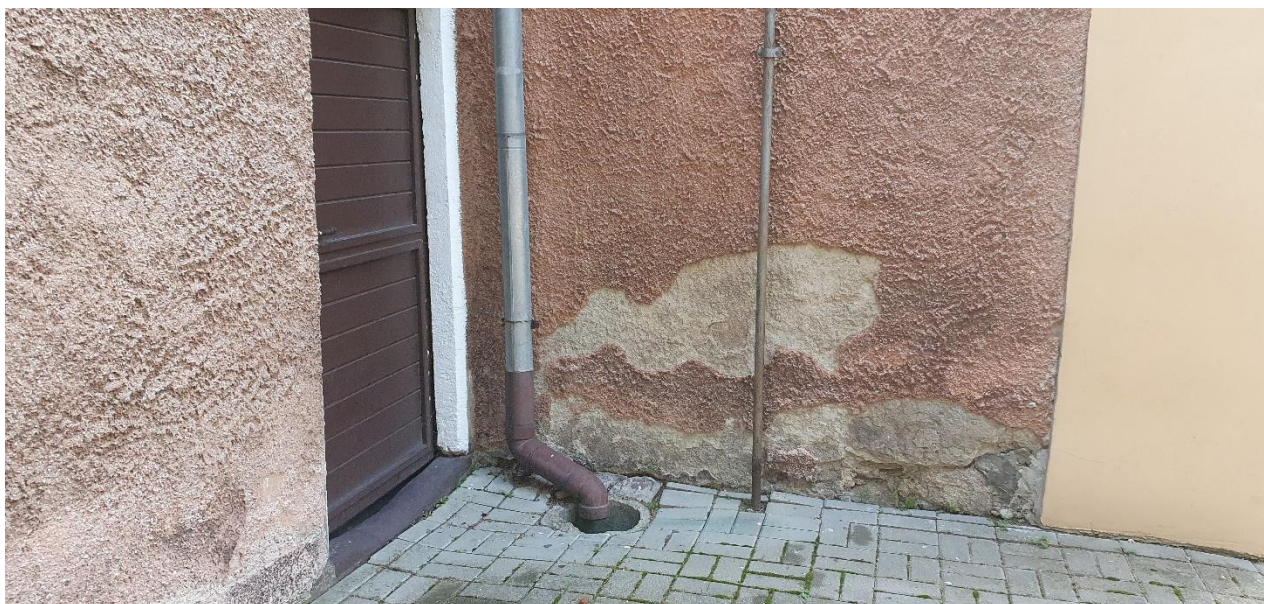
Masyw wieżowy od strony zachodniej kościoła – dolne partie. Zniszczenia elewacji w poziomie przyziemia.
