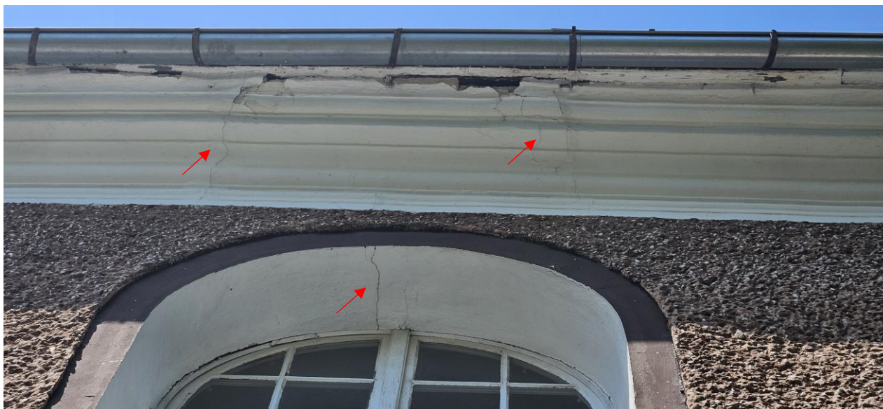
Przykład miejscowych zarysowań na elewacji
