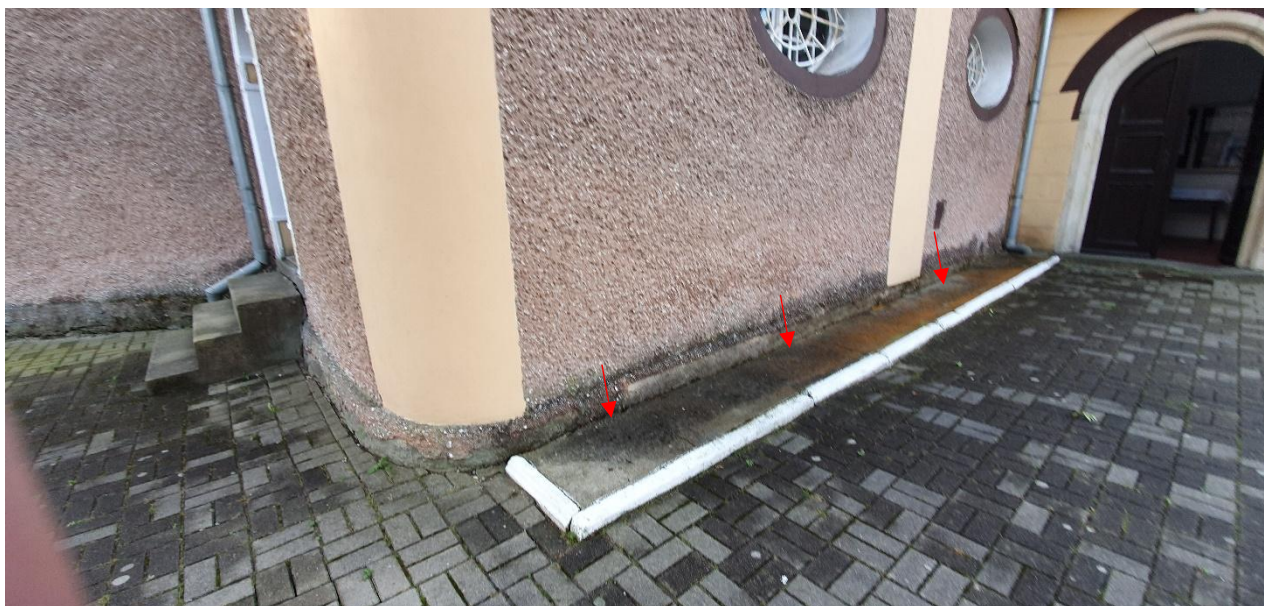
Przyziemie elewacji północno zachodniej z istniejącą opaską betonową od strony wejścia bocznego poprzez kruchnę.
