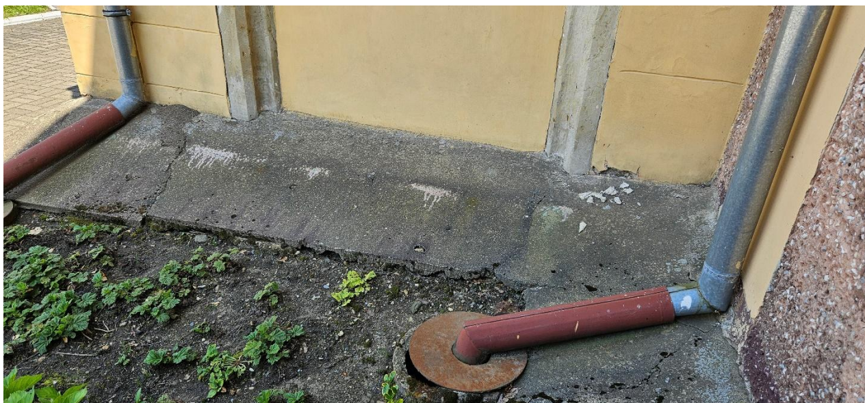
Przyziemie elewacji północno zachodniej z istniejącą opaską betonową od strony kruchty.
